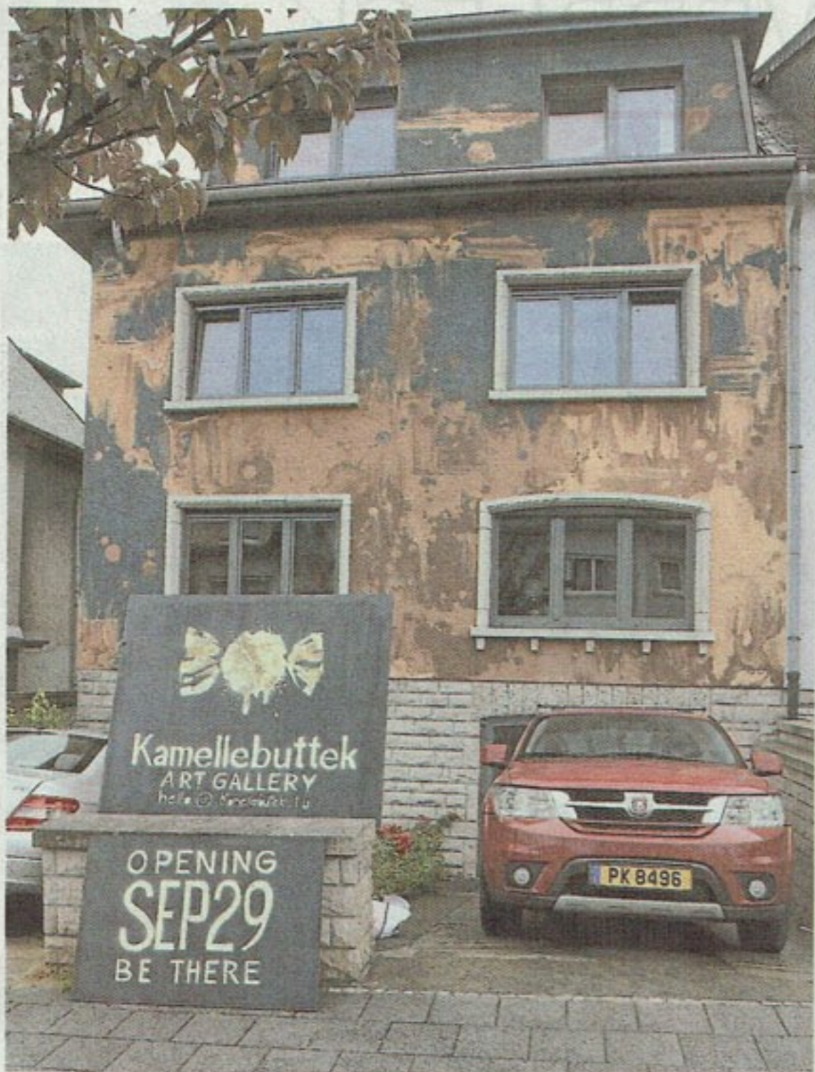
Die Fassade wurde erst vor zwei Wochen fertig
